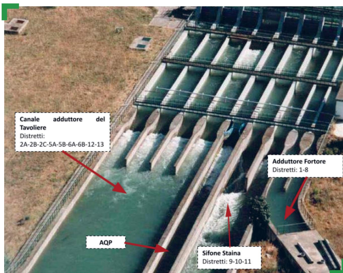
*Figura 13. Derivazioni che si dipartono dalla vasca di Finocchito, con indicazione degli adduttori*
