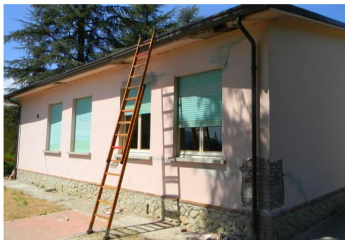
L'edificio è stato reso inagibile dall'Ordinanza n° 33/2012 in data 17/02/2012, a firma del Sindaco del Comune di Sogliano al Rubicone (FC), per via del crollo di parte della copertura e degli adiacenti cornicioni "in relazione al carico sulle strutture determinato dalle copiose nevicate avvenute nei giorni scorsi" (cit. dall'ordinanza).
